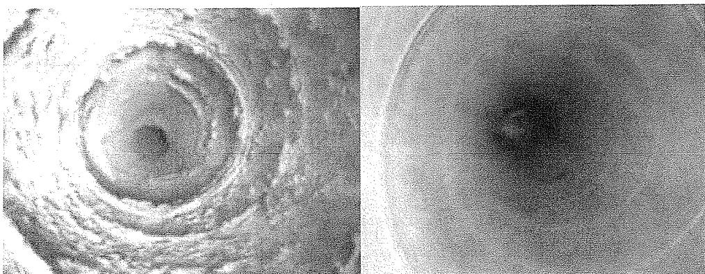
Prvým krokom pri údržbe vetracích potrubí je revízia jeho stavu, zistenie miery znečistenia a návrh opatrení k odstráneniu problémov. Do vetracieho potrubia sa zavádzajú inšpekčná kamera, pomocou ktorej možno monitorovať a vyhotoviť záznam o stave znečistenia potrubia.
